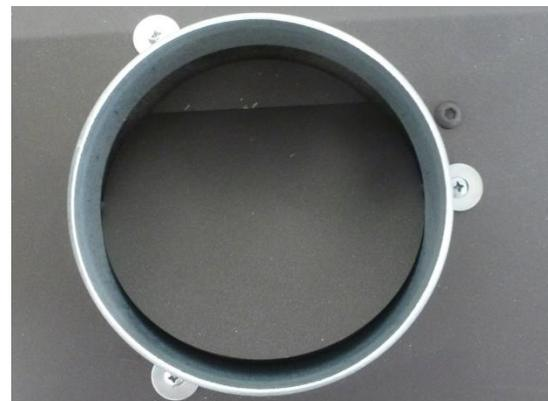
*Figura nº8 - Tobera correctamente atornillada en los 3 puntos con sus arandelas*
