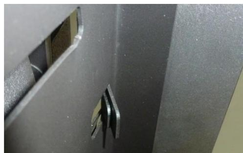
*Figura n°13 - Detalle de pestaña doblada*
