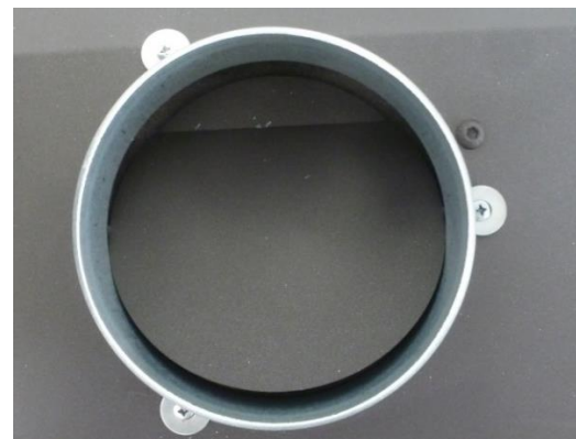
Figura nº8 - Tobera correctamente atornillada en los 3 puntos con sus arandelas
